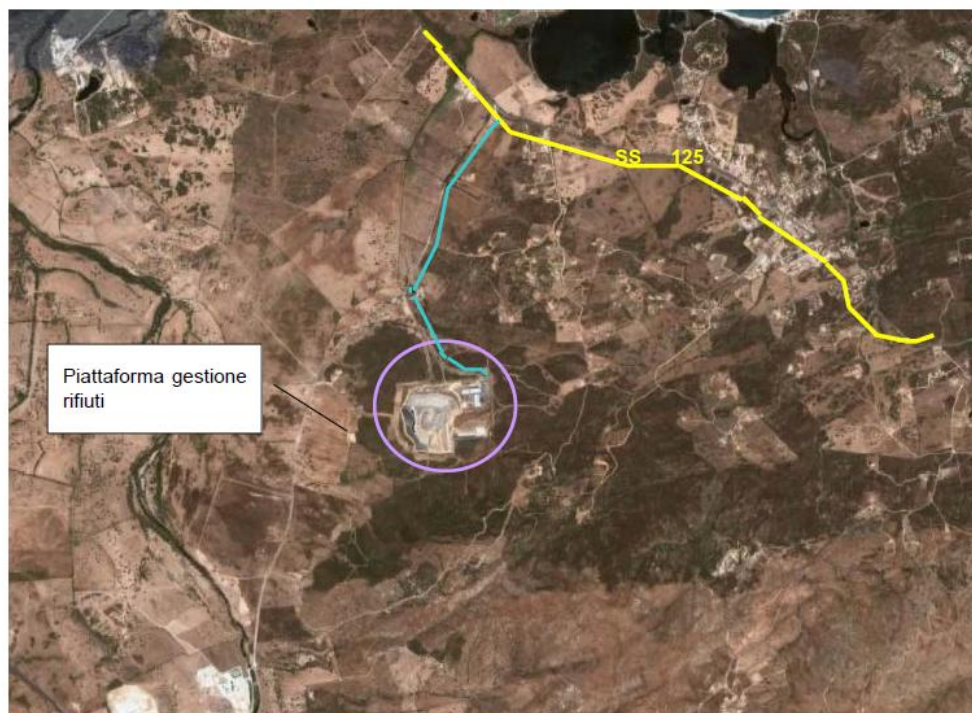
Figura 2.1-1: Inquadramento su foto aerea dove si evidenzia la viabilità di accesso al polo impiantistico
